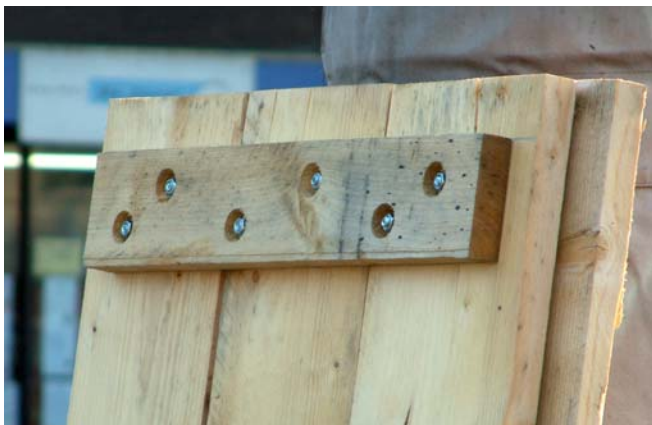
Foto S14 Modern, de klampen met bouten en moeren vastzetten.
