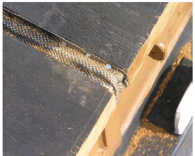
Foto B42 Sponning inkorten en de presenning afwerken.
