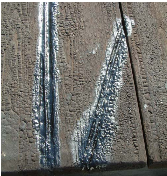
Foto S03 Een mooier ingezet stuk dat niet inwatert, zelfs met presenning.
