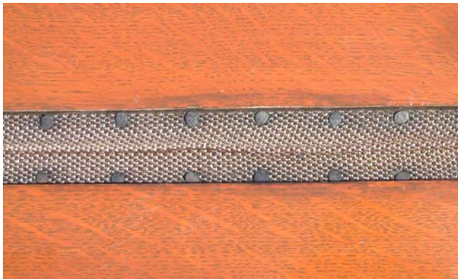
Foto S19 Band vlak in de sponning gespijkerd, recht spijkeren.
