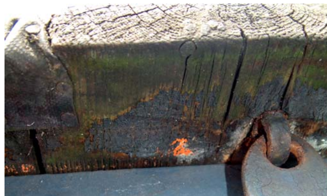
Foto S22 Presenningband aan de onderkant gespijkerd.
