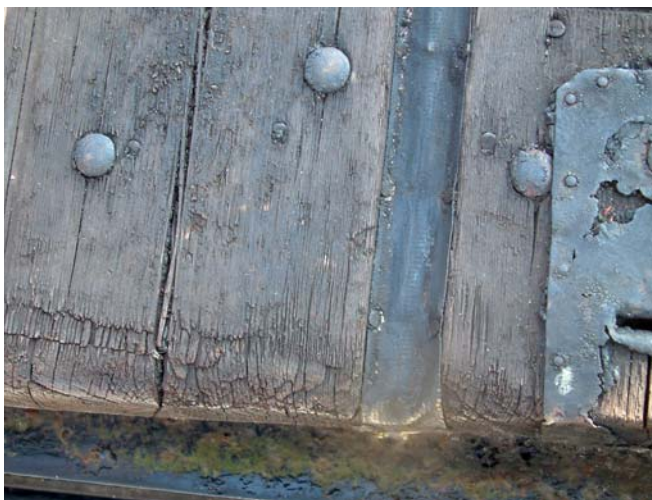
Foto S20 Band tegen de opstaande kant van de sponning, in de hoeken gespijkerd.
