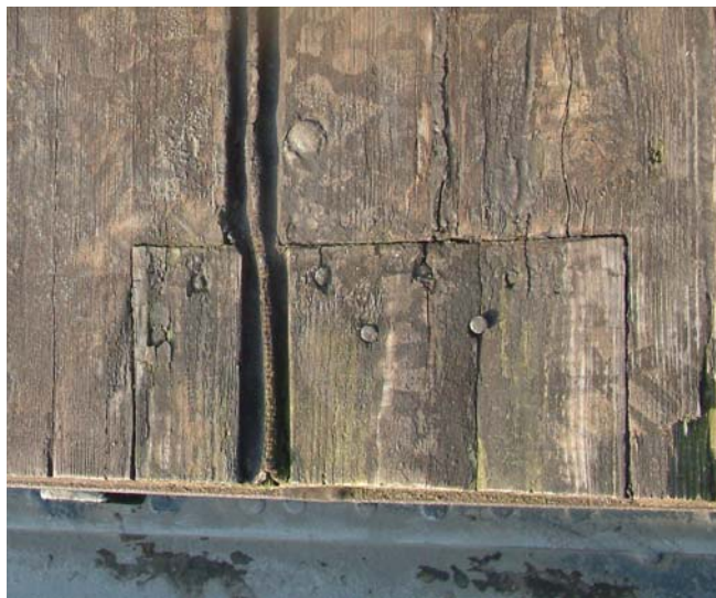
Foto S05 Dit watert op den duur in en rot los.
