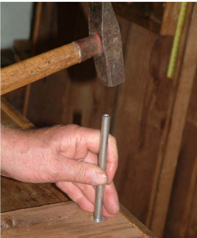
Foto B17 Boutjes doorsteken, ringetje erop. Daarna ringetje stuik slaan met een pijpje.
