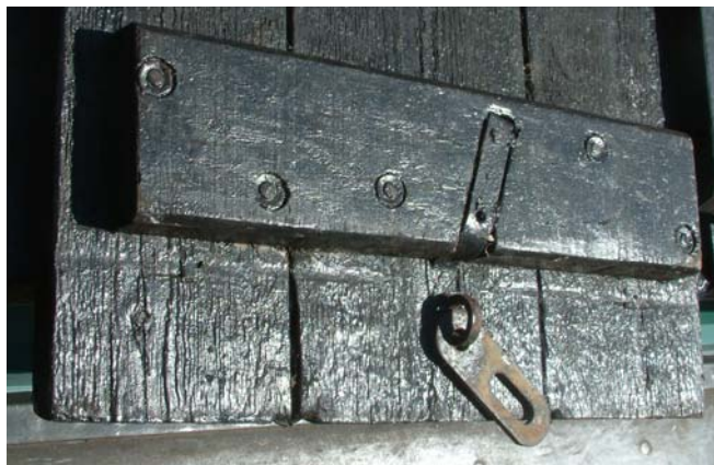
Foto S33 Verzegelklep, scheef, dat scheelt een boutje.
