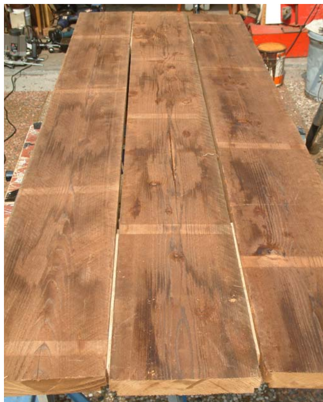
Foto B09 Afstandslatjes voor de planken.
