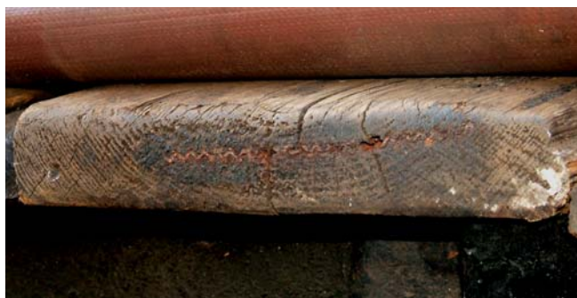
Foto S06 Gegolfd kramplaatje in de kop van een plank.
