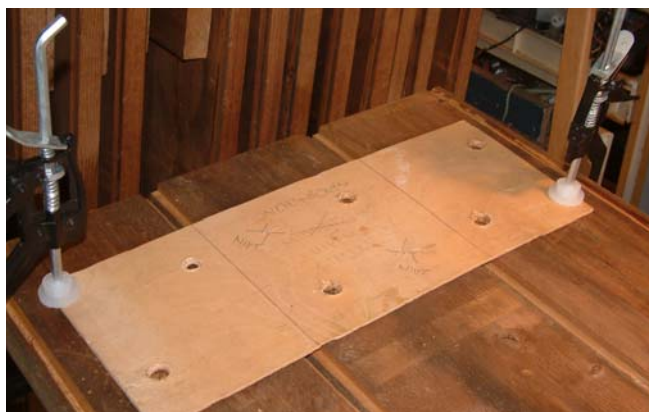
Foto B14 De boormal vastklemmen, gaten voor de bovenklamp boren vanaf de zichtkant.
