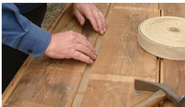
Foto B25 Overlappend in de sponning leggen, onder eerst i.v.m. afwateren.
