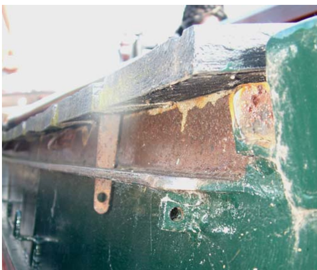
Foto S39 en S40 Voorbeeld van een verzegelstrip haaks op de den.
