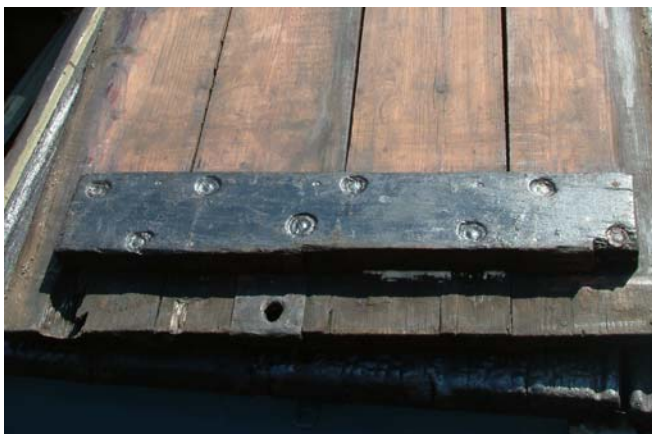
Foto S17 De originele manier van vastklinken van de ringetjes.
