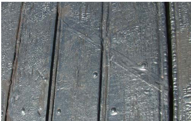
Foto S02 Een ingezet stuk, naden afgedekt.
