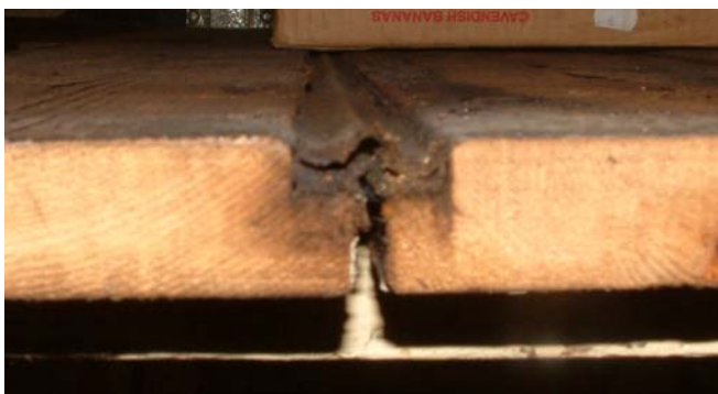
Foto S21 Doorsnede van een oud luik.
