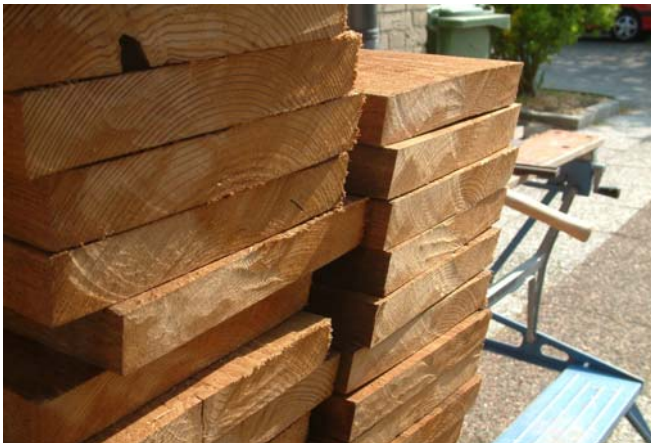
Foto B03 De planken en klampen schuin op maat gezaagd, onder pakweg 10-15 graden.
