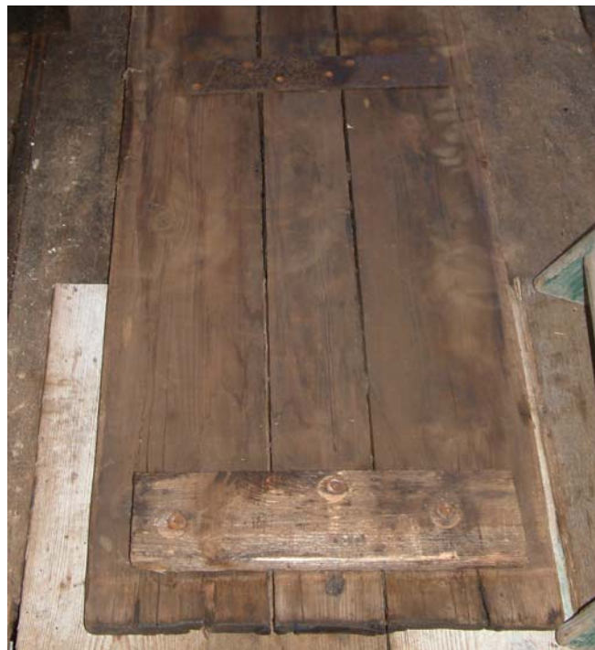
Foto S12 Van oudsher een plaatje ijzer geschroefd, in plaats van een houten klamp.
